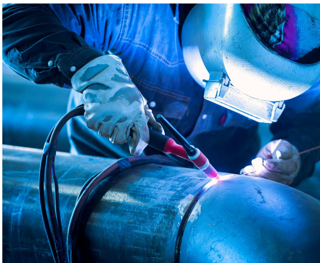
Travaux de soudage TIG exigeant le recours à un permis de feu, sur réseau
